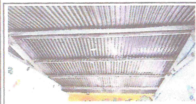
Foto 3: Cambio de lámina de las aulas
