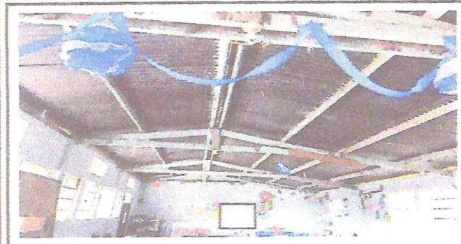
Foto 1: Cambio de vigas de madera del aula
