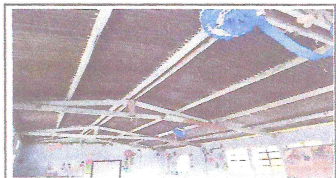
Foto 4: Cambio de lámina de las aulas
