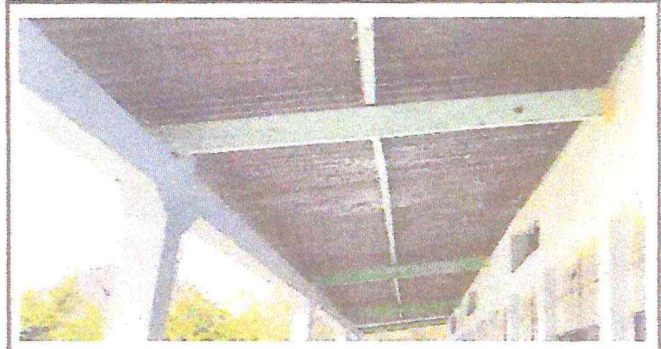
Foto 2: Cambio de vigas de madera del corredor
